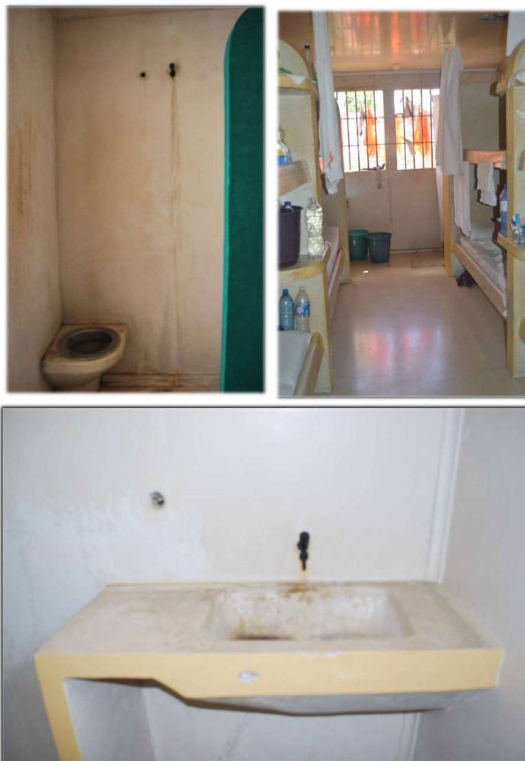
Figura 78: Estrutura da cela da unidade prisional. Fonte: MNPCT.
