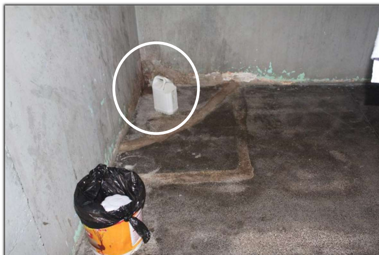
Figura 08: Alojamento da internação provisória. Fonte: MNPCT.
