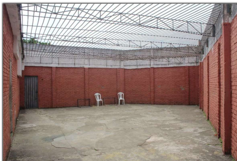
Figura 04: Local para prática de esportes. Fonte: MNPCT.
