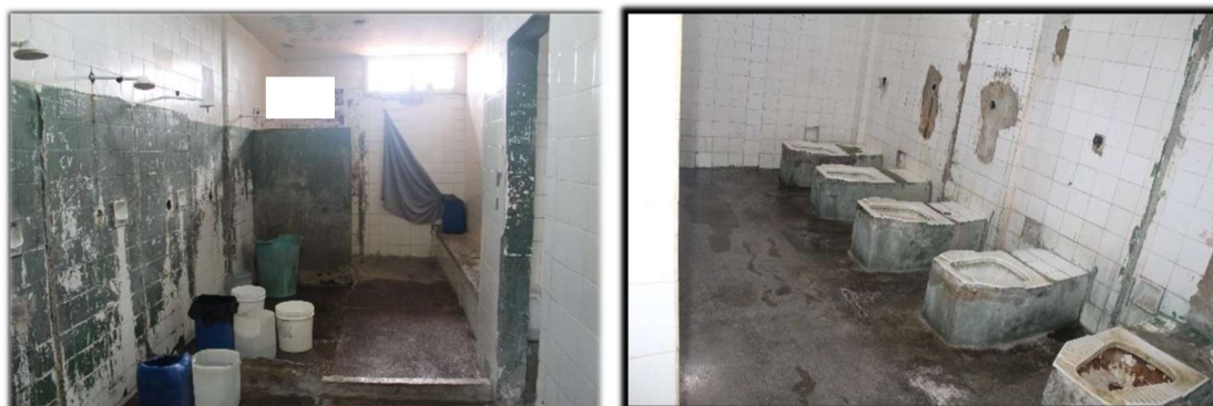
Figura 05: Estrutura do banheiro. Fonte: MNPCT
