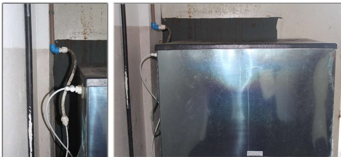
Figura 94: Bebedouro sem elemento filtrante. Fonte: MNPCT.
