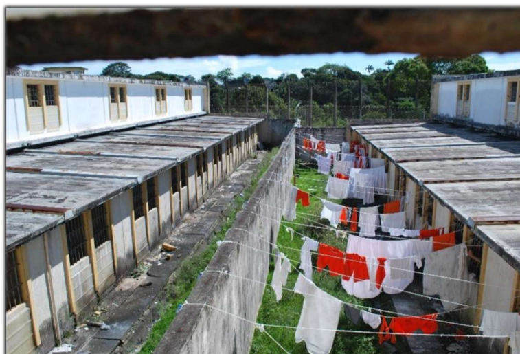
Figura 82: Área externa e fundo das celas. Fonte: MNPCT.
