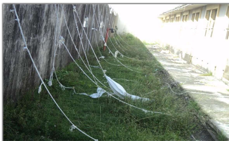
Figura 83: Área externa e fundo das celas. Fonte: MNPCT.
