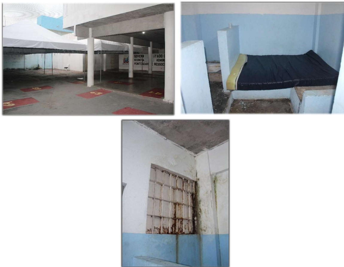
Figura 87: Pátio semicoberto para visita social (E) e local das visitas íntimas. Fonte: MNPCT.
