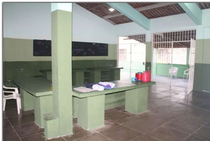
Figura 22: Área central dos módulos onde são realizadas as refeições. Fonte: MNPCT.
