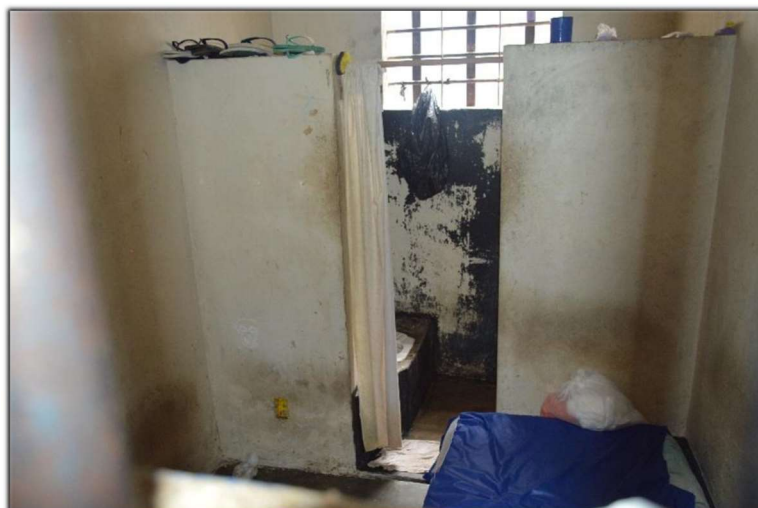
Figura 91: Cella da triagem. Fonte: MNPCT.
