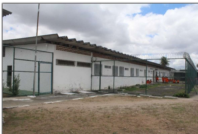
Figura 63: Área para banho de sol do pavilhão feminino. Fonte: MNPCT
