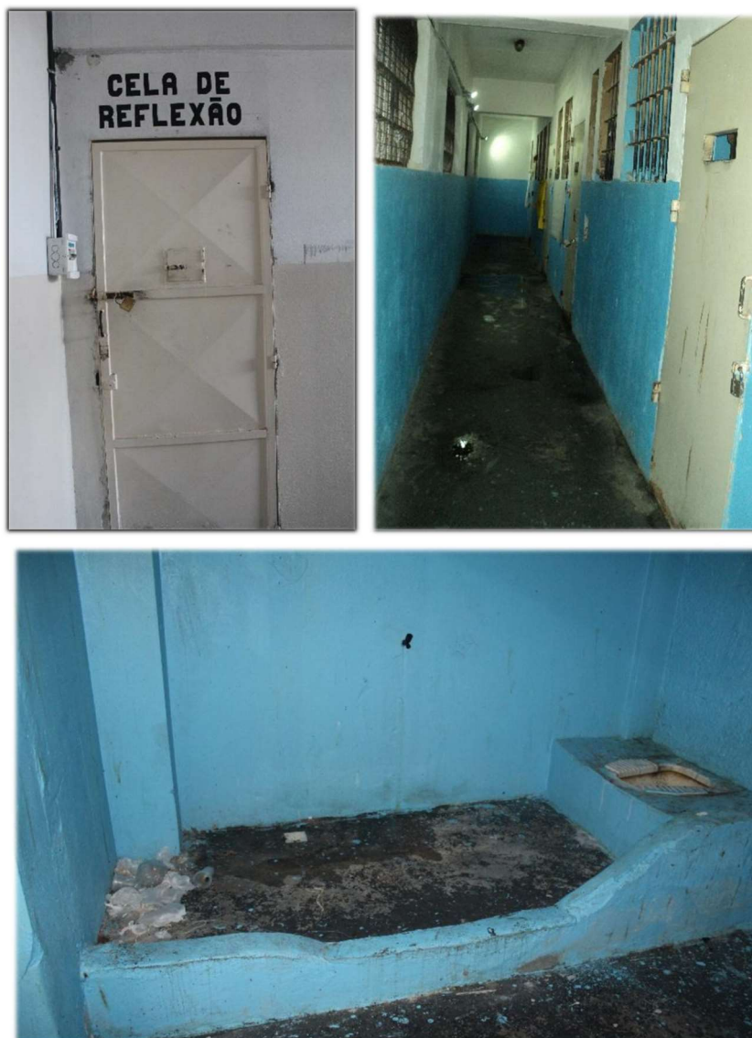
Figura 89: Local destinado ao isolamento de pessoas presas. Fonte: MNPCT.
