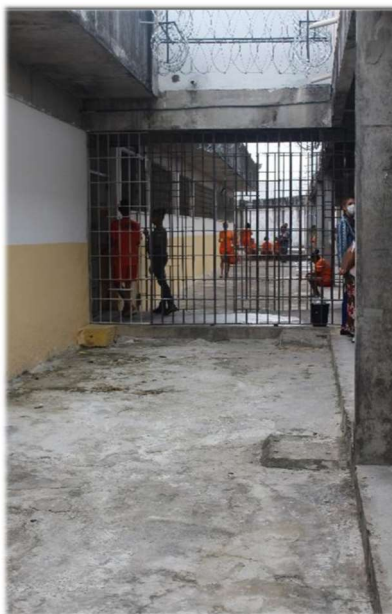
Figura 35: Área que poderia ser utilizada, no caso de adequação. Fonte: MNPCT.
